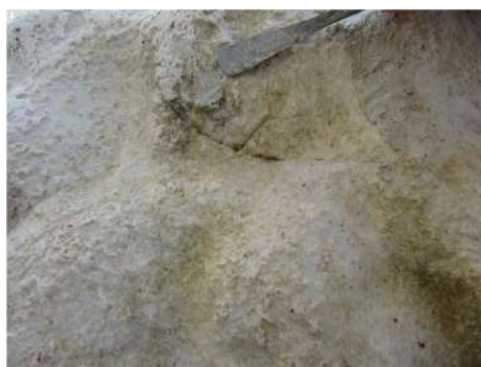
Fig. 7.4 - In alto: preparazione della malta con aggiunta di NopalCap; in basso: esecuzione della microstuccatura
