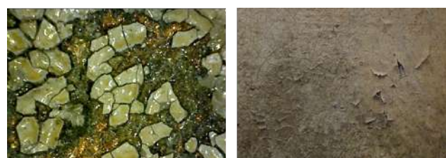
Fig. 7.12 - Sfogliamenti di strati preparatori sovrapposti
