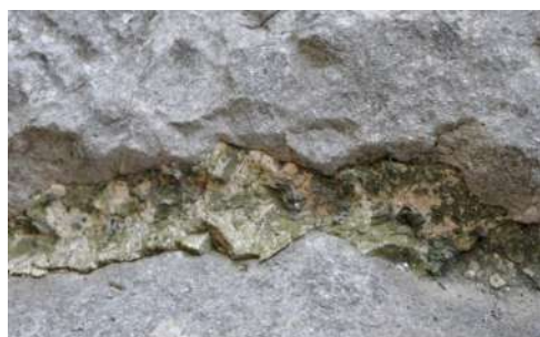
Fig. 7.7 - Patine biologiche sulla superficie di due grandi stuccature in malta cementizia
