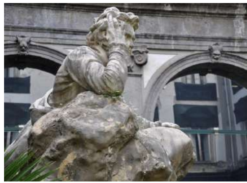
Fig. 7.6 - Particolari dell'opera in cui si evidenzia la presenza di patine scure di natura biologica e di piante superiori
