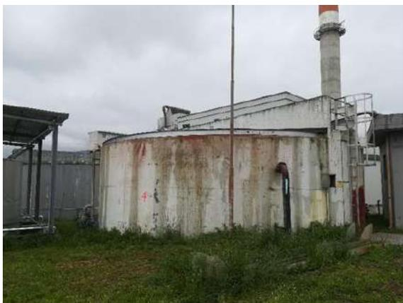
La produzione di VFA (Volatile Fatty Acids – Acidi Grassi Volatili) da fanghi di depurazione avviene tramite una fase di fermentazione mesofila controllata con culture microbiche miste (pH 5.5 -6.0 e temp 35°C) e con tempi di residenza di 4-5 giorni. Nel caso di Sesto si sfruttano volumi esistenti opportunamente modificati (ispessitore statico convertito a fermentatore).
